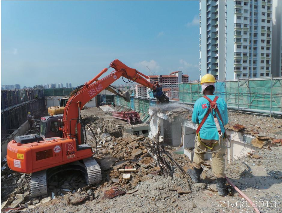
構築物拆除服務指通過應用壓碎、破碎及切割等不同方法拆解及移除樓宇結構的混凝土或金屬塊件或組件及整樓拆除。我們通常採用一種或多種拆除方法組合進行構築物拆除。拆除方法的主要類別載列如下：
