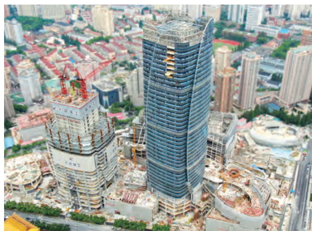
○ 上海ITC兩幢地標式寫字樓正在施工
