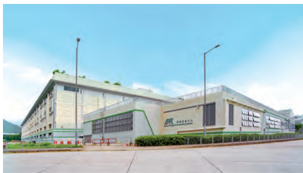
○ 香港機場空運中心
