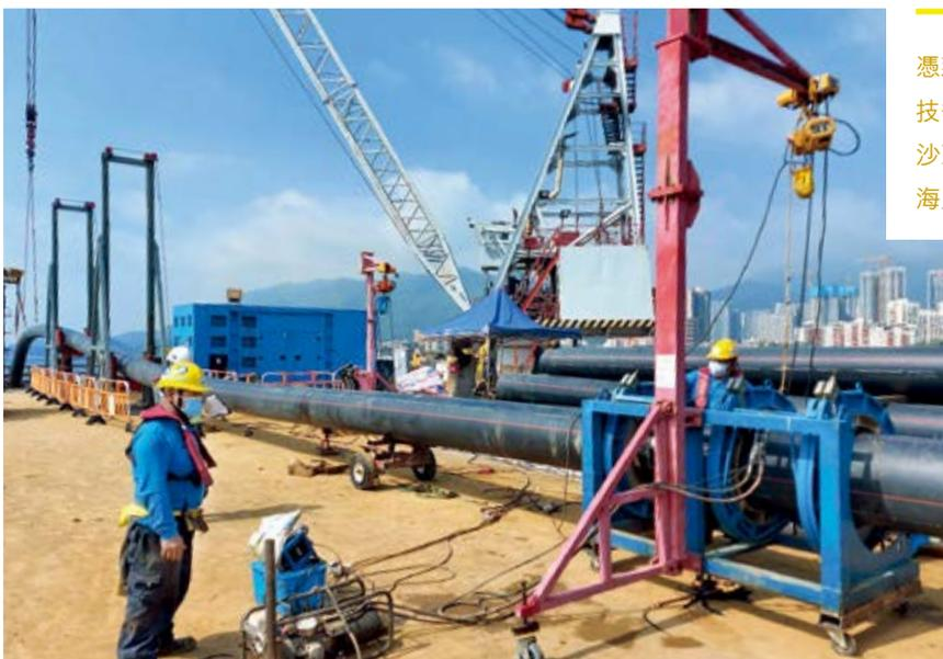
憑藉先進之聚乙烯管熔接技術，卓裕為渠務署在沙頭角建造1.9公里長之海底排污管。
