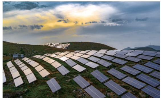
河南省淇縣廟口集中式光伏發電站
