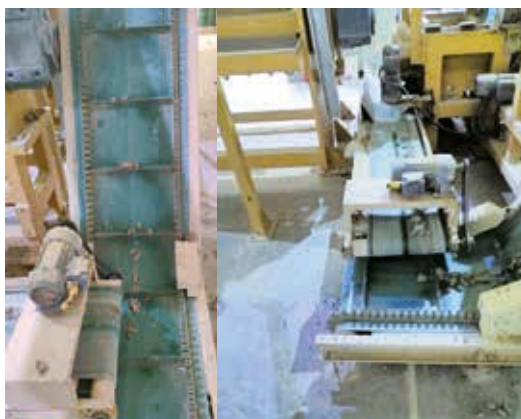
成型線加裝泥料回收裝置
