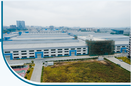
立信染整機械(廣東) 中山廠房
