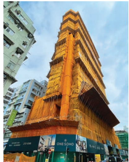
▲ 上蓋建築工程施工中 該照片攝於2022年6月15日，並已使用電腦影像技術進行編輯及處理。
