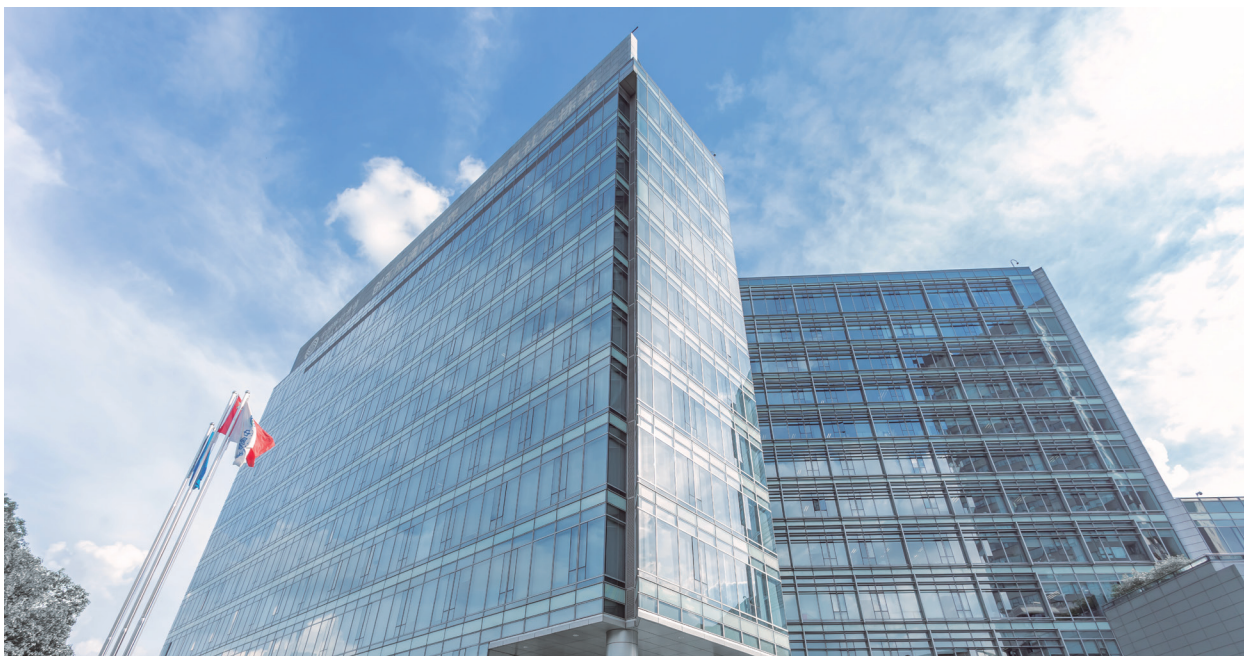
江蘇省移動通信樞紐大樓 JIANGSU MOBILE COMMUNICATION HUB BUILDING
