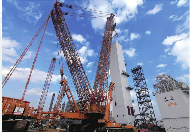
沙特 SABIC GAS Phase-9 空分項目
