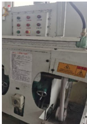
拋光打磨機及噴塗綫 升級完善氬氣警報系統、 水量水位計等安全裝置
