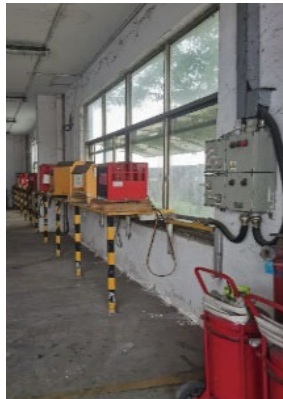
叉車充電區專項治理— 獨立房間隔離、 消防應急措施配置
