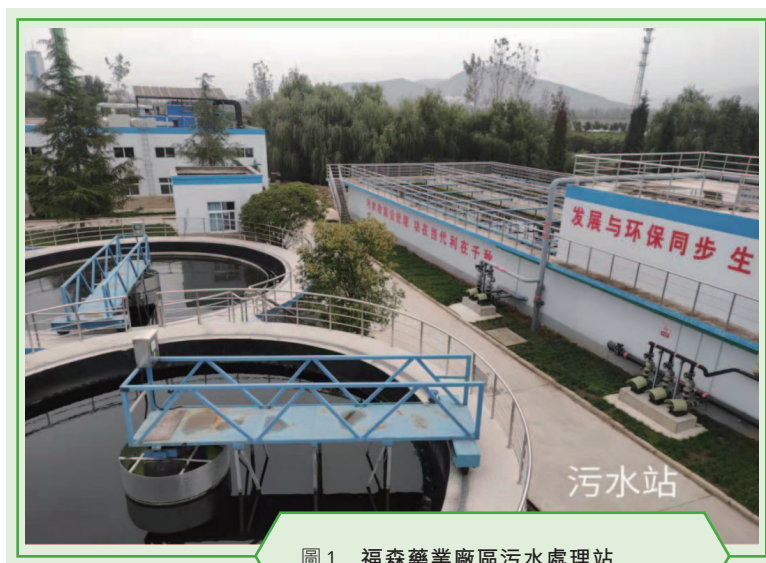
圖 1 福森藥業廠區污水處理站
