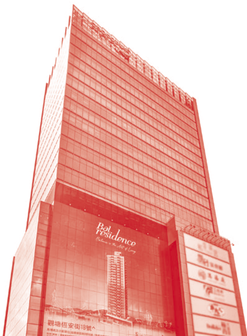
封面圖片 鱸魚恤中心 位於香港九龍開源道之商廈
