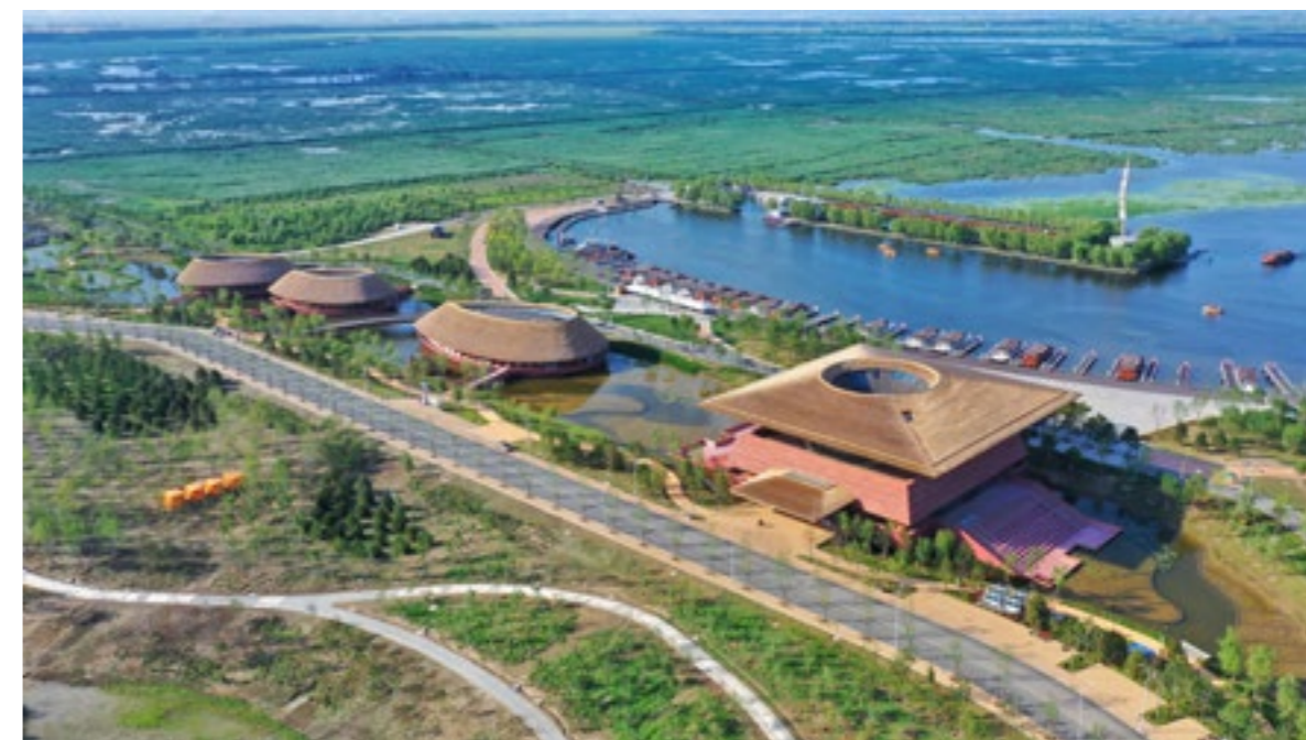
▲ 本行河北分行金融支持雄安新區白洋澗綜合生態修復項目。
