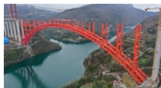
▲ 本行貴州分行貸款支持的烏江特大橋。
