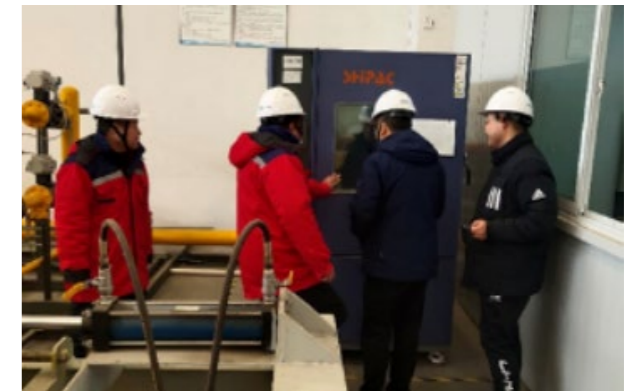
与供应商进行现场协调
