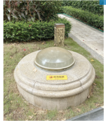
利用天然光源 節省地庫照明成本
