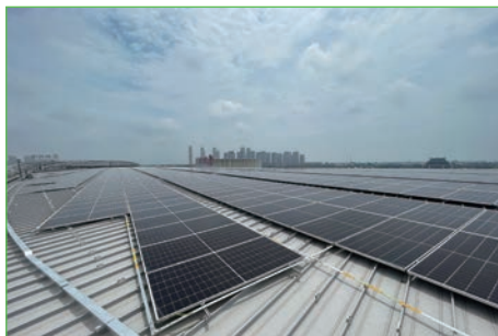
無錫熱雪奇跡屋面光伏 實施完成
