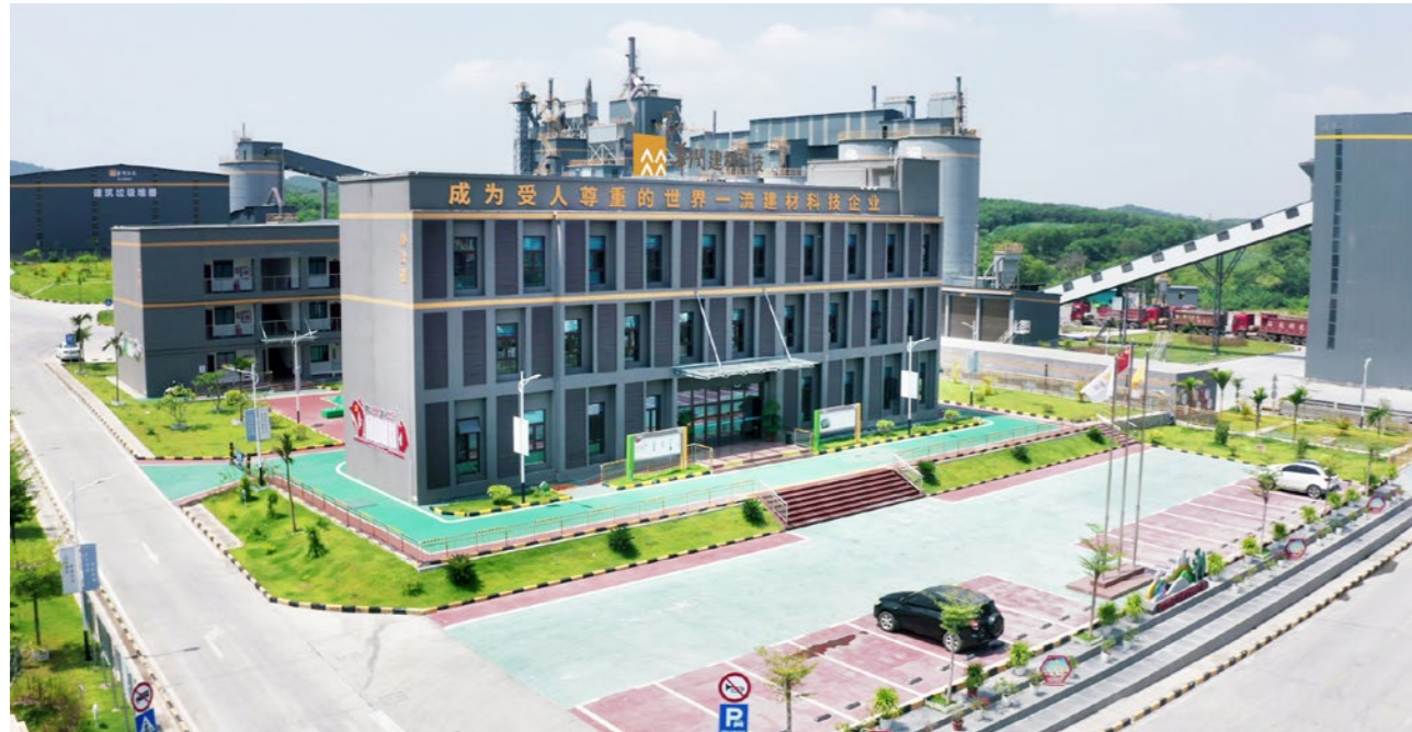
昌江水泥建筑垃圾协同处置项目
