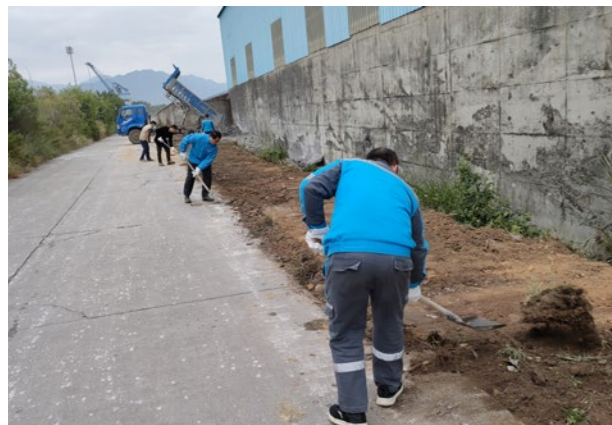
肇庆混凝土协助塘口村修建村道
