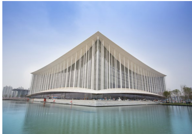
西安国际会展中心项目
