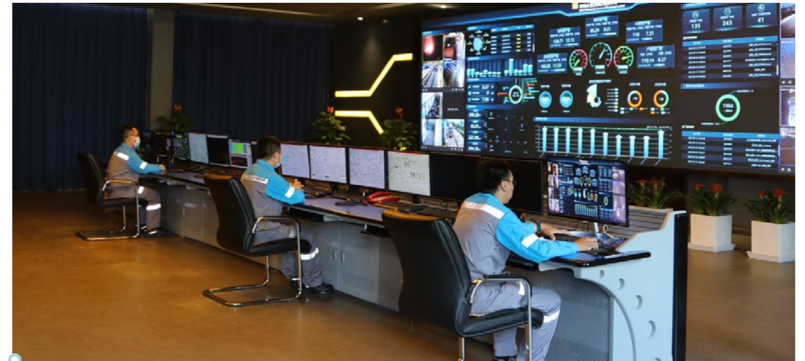
田阳水泥中控室
