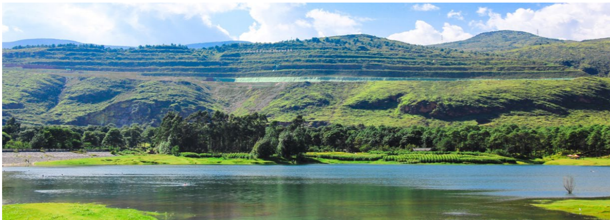
安顺水泥年产 100 万方混凝土、200 万吨骨料项目竣工投产
