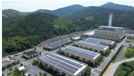
湖州威能環境服務有限公司0.93兆瓦光伏發電項目
