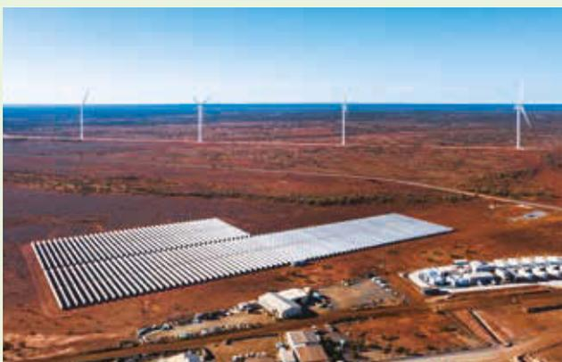
EDL 的 Agnew 混合式可再生能源項目是澳洲最大型的可再生能源微電網，亦是創新混合能源發電的試點。這個 56 兆瓦的微電網位於 Gold Fields Agnew 金礦場，混合風力、太陽能和火力發電，並設有蓄電池。
