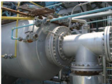
硫回收設備使用的燃燒器負責將煙氣、酸性氣體及助燃空氣混合成一定的形式，並通過將混合物噴入火道及火爐產生燃燒反應。高效的燃燒器可以提高熱反應器中元素硫的轉化率，消除銨鹽或其他雜質的重烴對下游設備的影響，並確保硫回收設備的效率及可靠運行。
