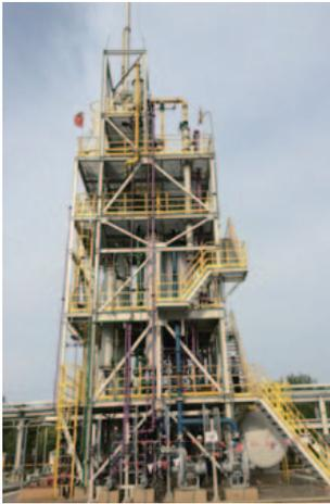
氯氟烴焚燒系統在攝氏1,200度的熔爐內以高溫燃燒氯氟烴，接著在灑水冷卻後進入洗滌器，避免產生二噁英，有效去除煙氣中的有害物質。
