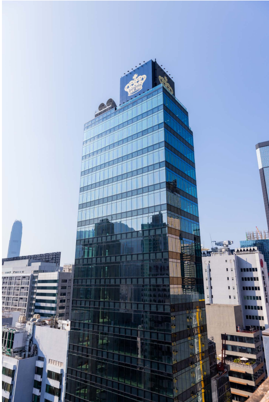
GF Tower 廣發大廈
