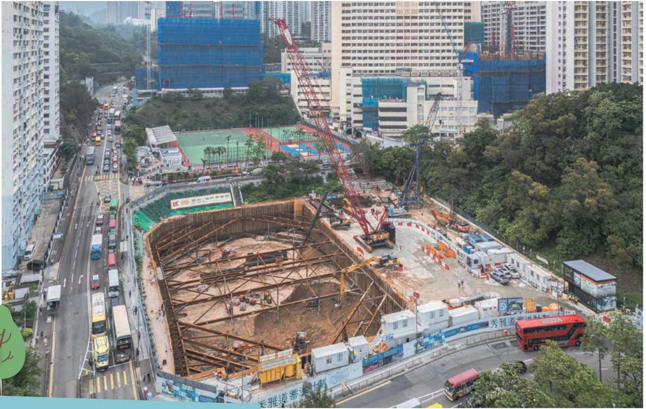
Sau Nga Road Stormwater Storage Scheme 秀雅道地下蓄洪計劃
