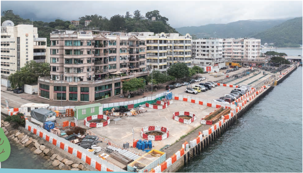
Improvement Works at Mui Wo, Phase 2 Stage 2 梅窩改善工程第2期第2階段
