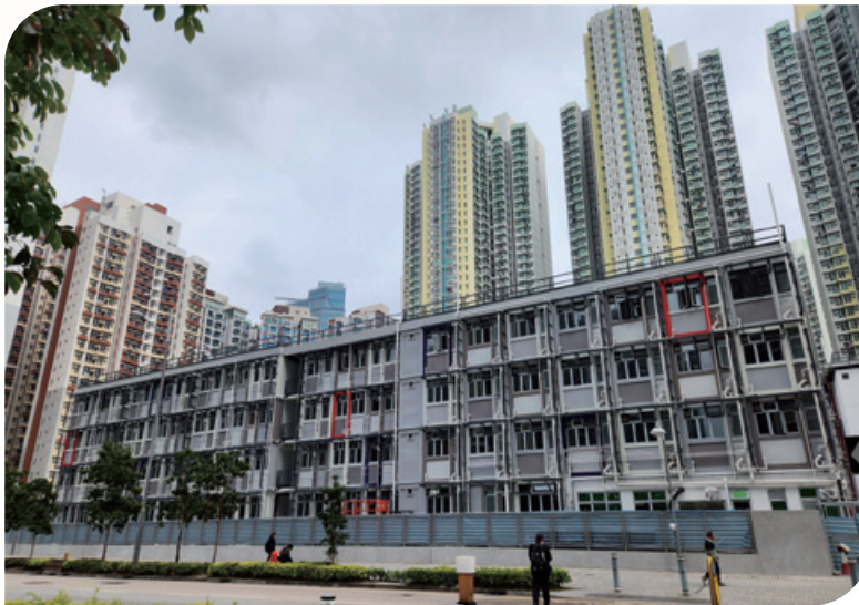
Transitional housing at Area 1B2, Muk On Street, Kai Tak 啟德沐安街第1B2區過渡性房屋項目
