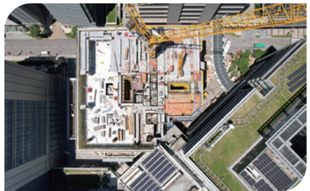
Hong Kong Science Park Expansion Stage 2 (SPX2) Building 12W-A 香港科學園第二期擴建工程12W-A大樓項目
