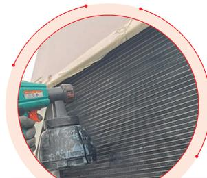
碳膜塗層處理前之冷水機冷凝器
