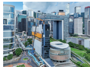
第一項 MiC 多層寫字樓建築工程
